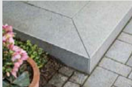
Gehrungsschnitte bei Blockstufen – ob Naturstein oder Keramik-Verbund-Produkte ...
